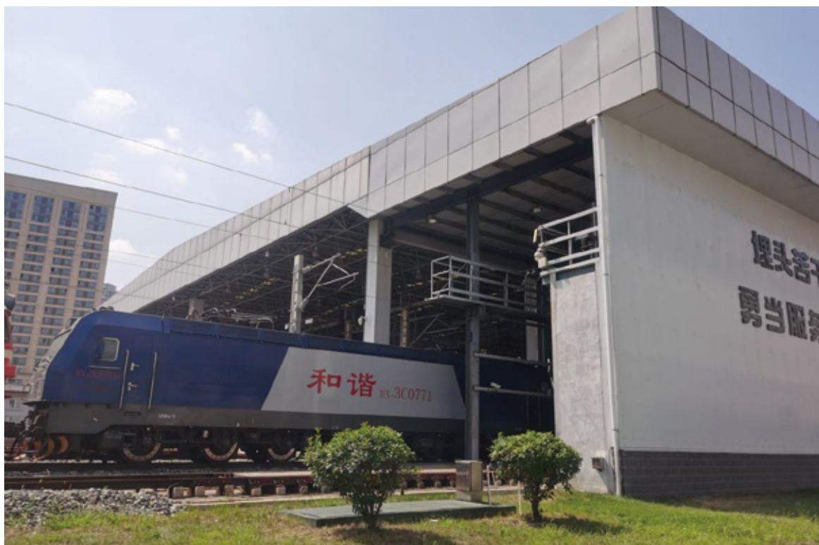
▲ 图1 机务段整备车间
